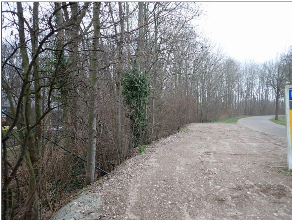
Foto 21: opgehoogde groeiplaatsen, puinfundering voor parkeerplaats in deelgebied C
