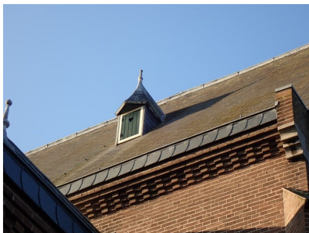
Foto 15: links, oostzijde van de kerk met de afwerking tussen dak delen met lood en zink
