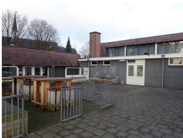
Foto 2: rechts, overstek van de uitgekraagde kap met aan de onderzijde plaatmateriaal bewerkt als schroten.
