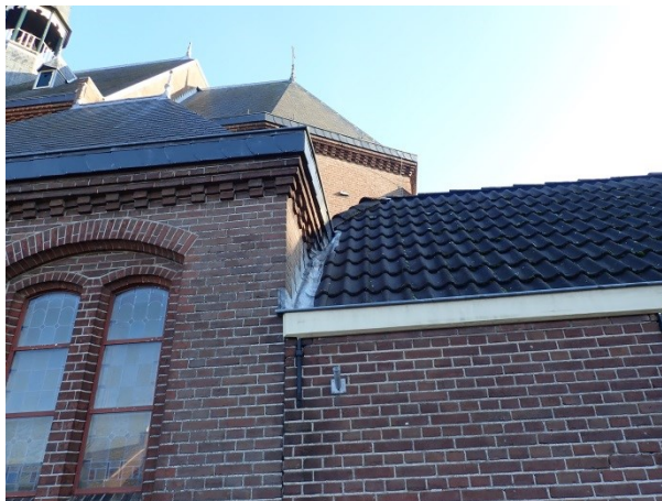
Foto 17: links, regenpijp met uitwerpselen van een vogel op het metselwerk. De vogel heeft tussen de pijp en het metselwerk voldoende ruimte om weg te kruipen.
