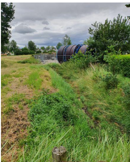
Figuur 5 Bestaande watergang VVL-terrein, deze is in de huidige vorm te klein om de afvoer uit Rodingsveen te verwerken
