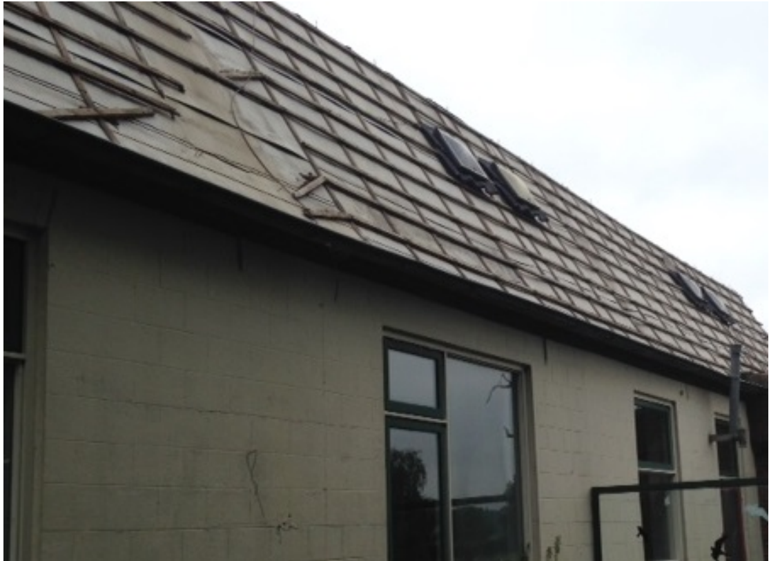
Verwijderde pannen door stormschade en asbestonderzoek.
