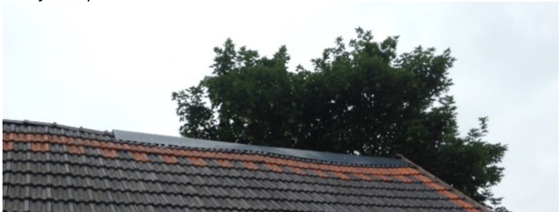
Verwijderde pannen door stormschade en asbestonderzoek.
