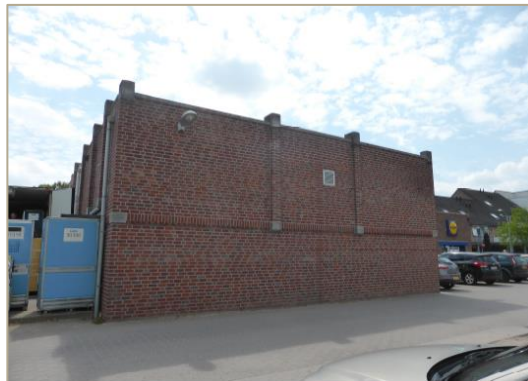
Figuur 3.3: Aanzicht van de noordgevel
