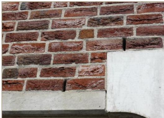
Figuur 3.5: Stootvoegen boven de raampartij
