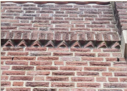
Figuur 3.4: Stootvoegen nabij het dak
