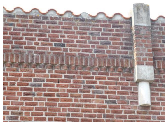
Figuur 9. Open stootvoegen in spouwmuur
