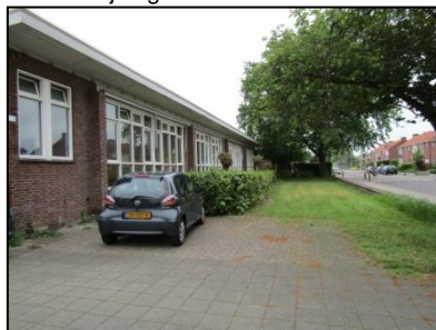
Figuur 7. De oostelijke grens gelegen aan de weg.
