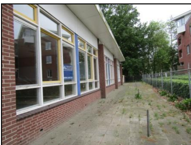
Figuur 6. De noordelijke grens van de onderzoekslocatie.
