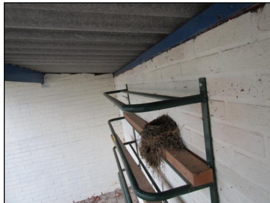
Figuur 11. Het aangetroffen nest in fietsschuur.
