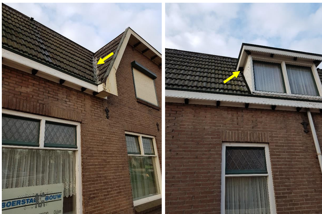
Figuur 6: Potentiële nestlocaties voor de gierzwaluw en huismus en verblijfplaats voor vleermuizen langs de kilgoot (links) en de dakkapel (rechts).
