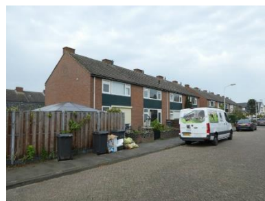
Figuur 2-5. Woningen aan de Van den Berghweg.
