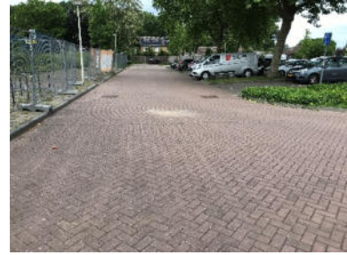
foto 6 - ter plaatse van asbestgat G02
