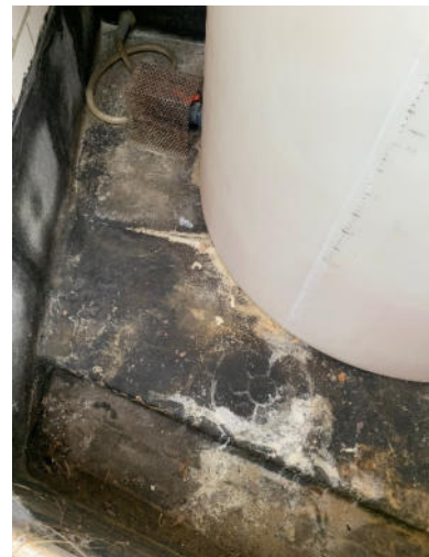
Opvangkuip met dubbele wand
