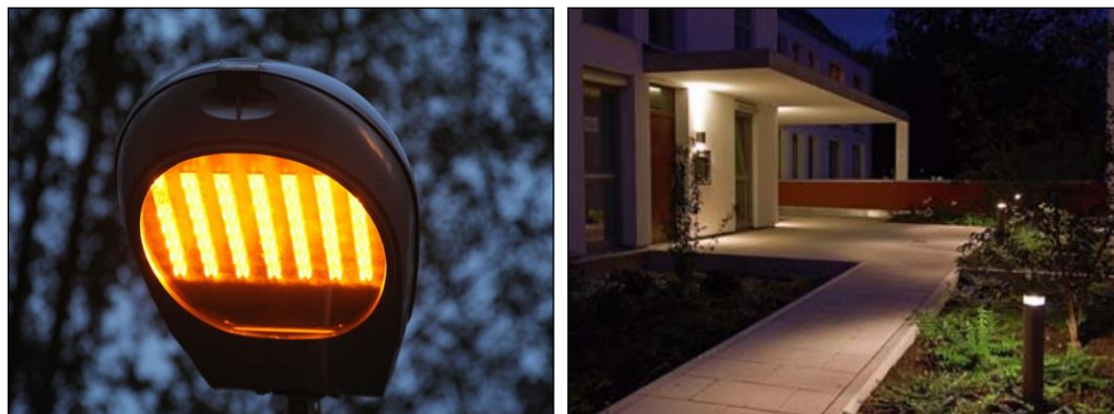
Vleermuisvriendelijke, amberkleurige ledverlichting (links) en een voorbeeld van juiste oriëntatieverlichting (rechts).
