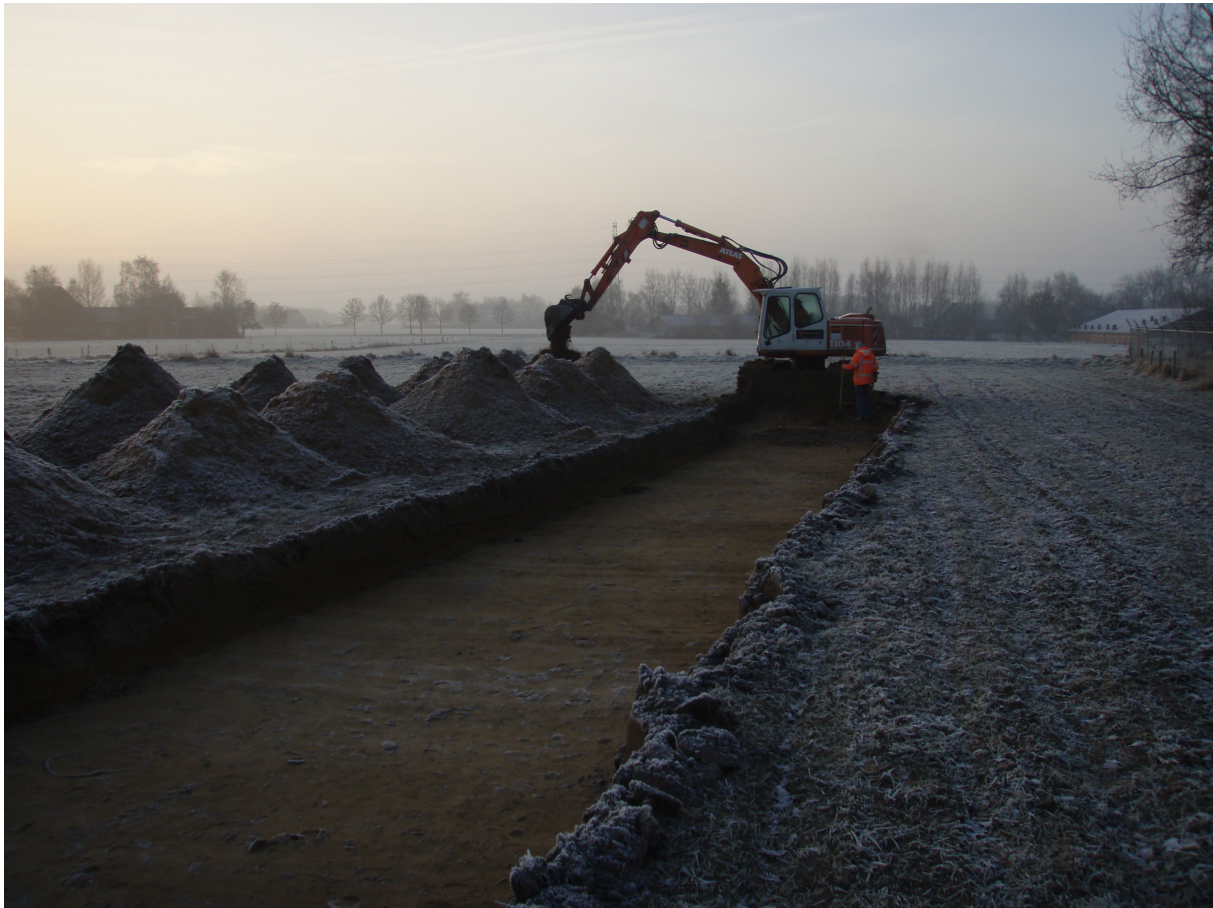
Afb. 4. Didam Westelijke Randweg, aanleggen van een proefsleuf.
