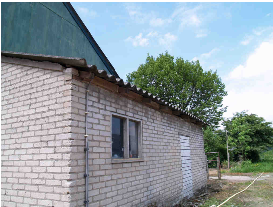
Aanbouw van de koeienstal zonder dakbeschot.
