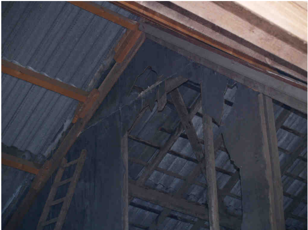
Dakconstructie van de kapschuur-annex koeienstal; geen beschoten kap, geen nestkasten.
