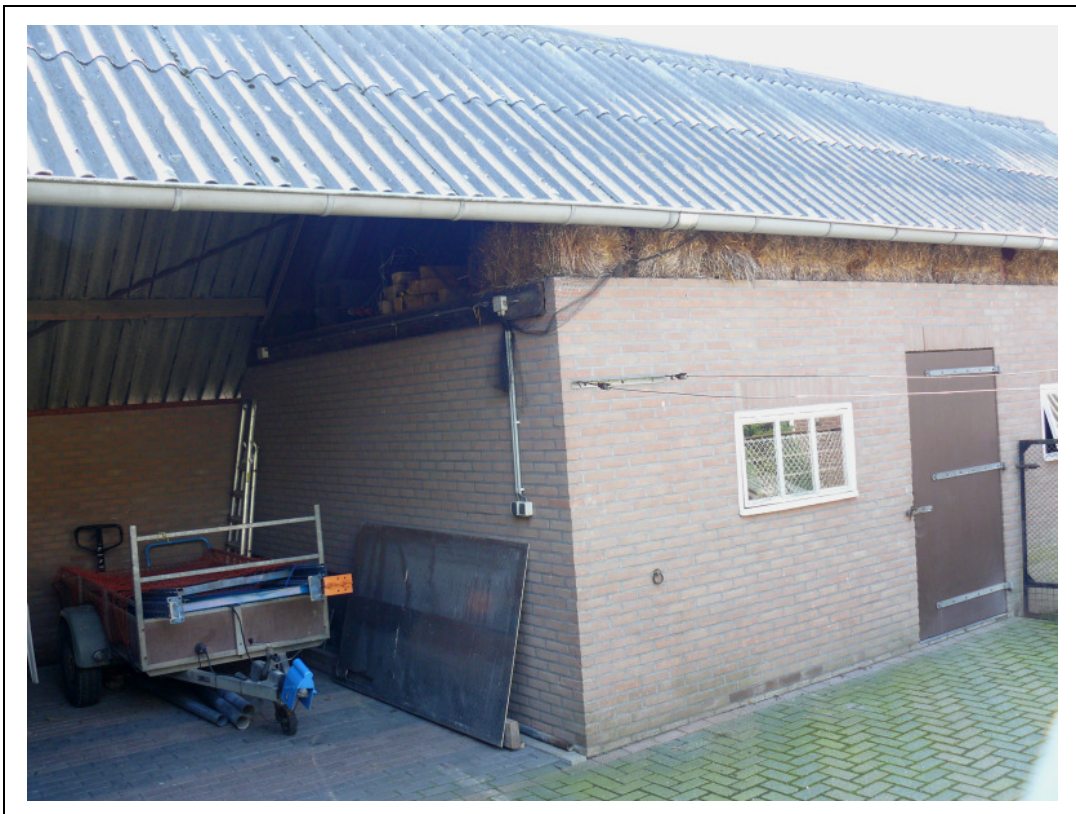
Foto 6. Boven de paardenstal bevindt zich een hooizolder.
