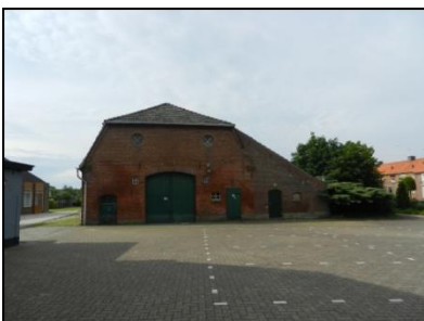
Figuur 6. Voorzijde schuur (te slopen).
