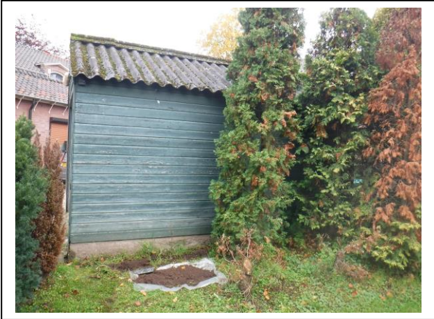
Foto: Inspectiesleuf SL2
