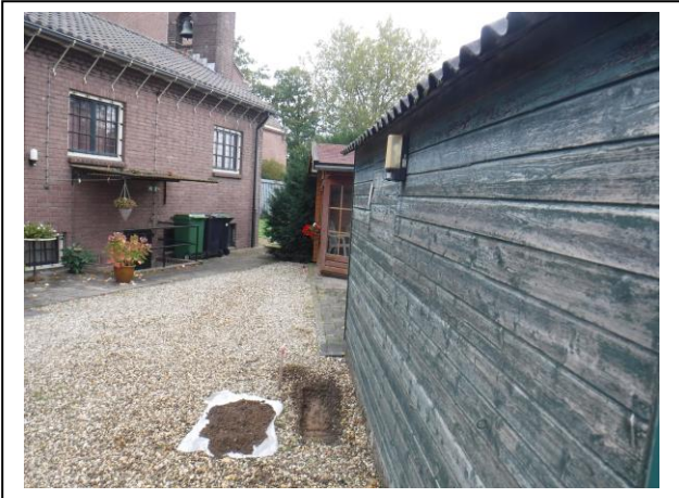
Foto: Inspectiesleuf SL1
