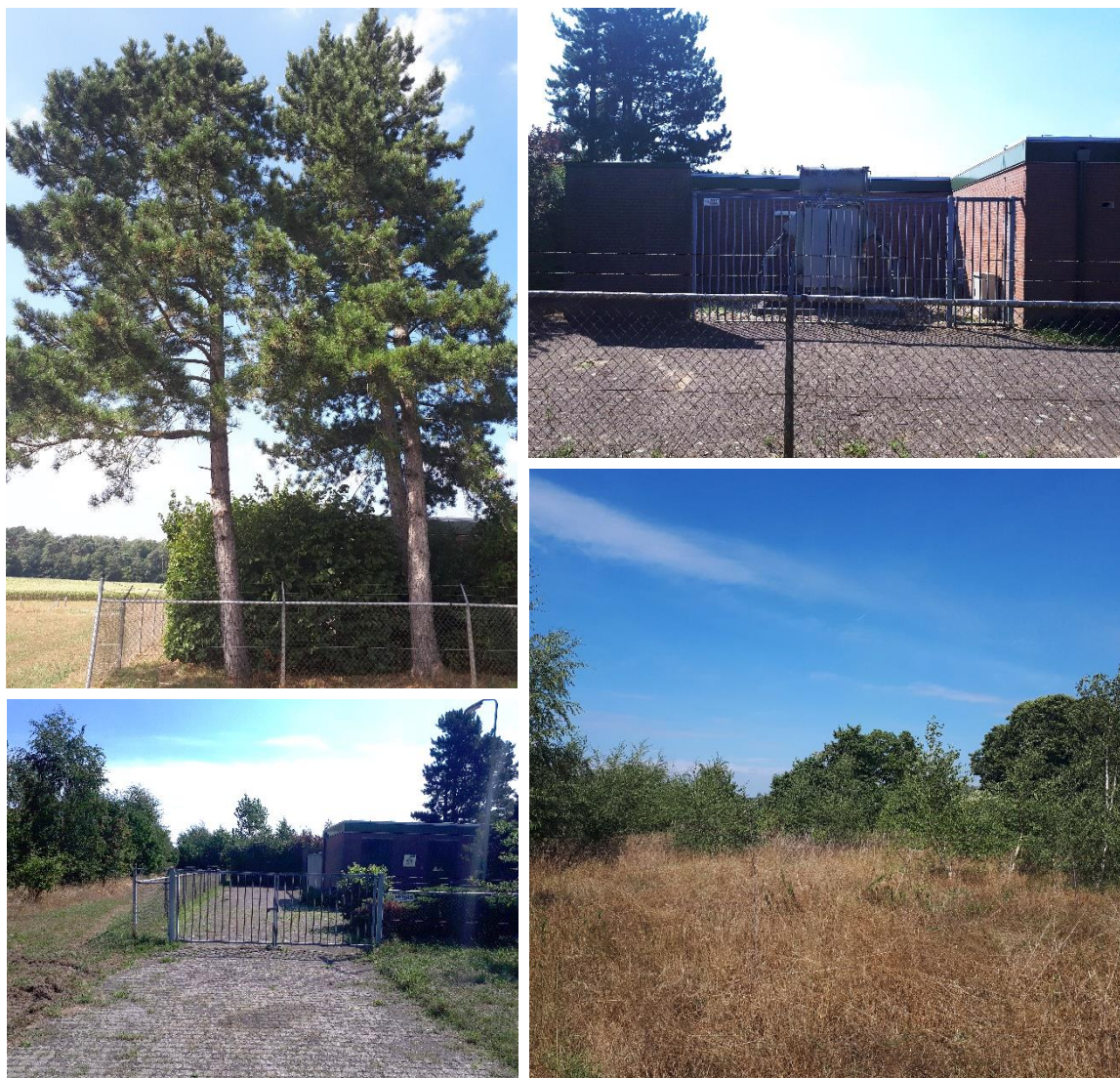
Figuur 2. Hekwerk met grove dennen en gemengde haag (linksboven), zijaanzicht van het elektriciteitsgebouw (rechtsboven), oprijlaan met het vooraanzicht van het elektriciteitsgebouw op de achtergrond (linksonder) en een overzicht van braakliggend terrein (rechtsonder).
