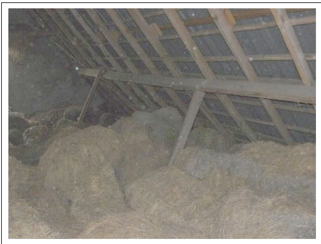
Foto 4. Hooizolder boven varkensschuur, broedlocatie holenduif.
