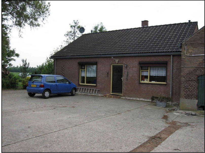
Bestaande semi-bungalow, te handhaven als bijgebouw (garage/ berging) bij woning nr. 8
