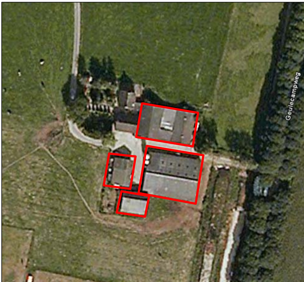
Figuur 2. Luchtfoto van het plangebied met te slopen bebouwing.
