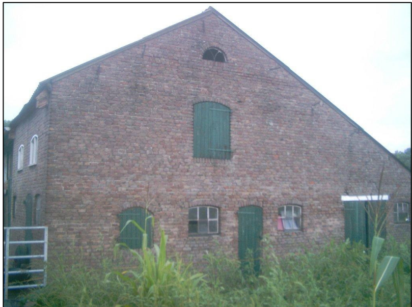
Bestaande kapschuurmodel schuur, te handhaven als bijgebouw bij te herbouwen woning
