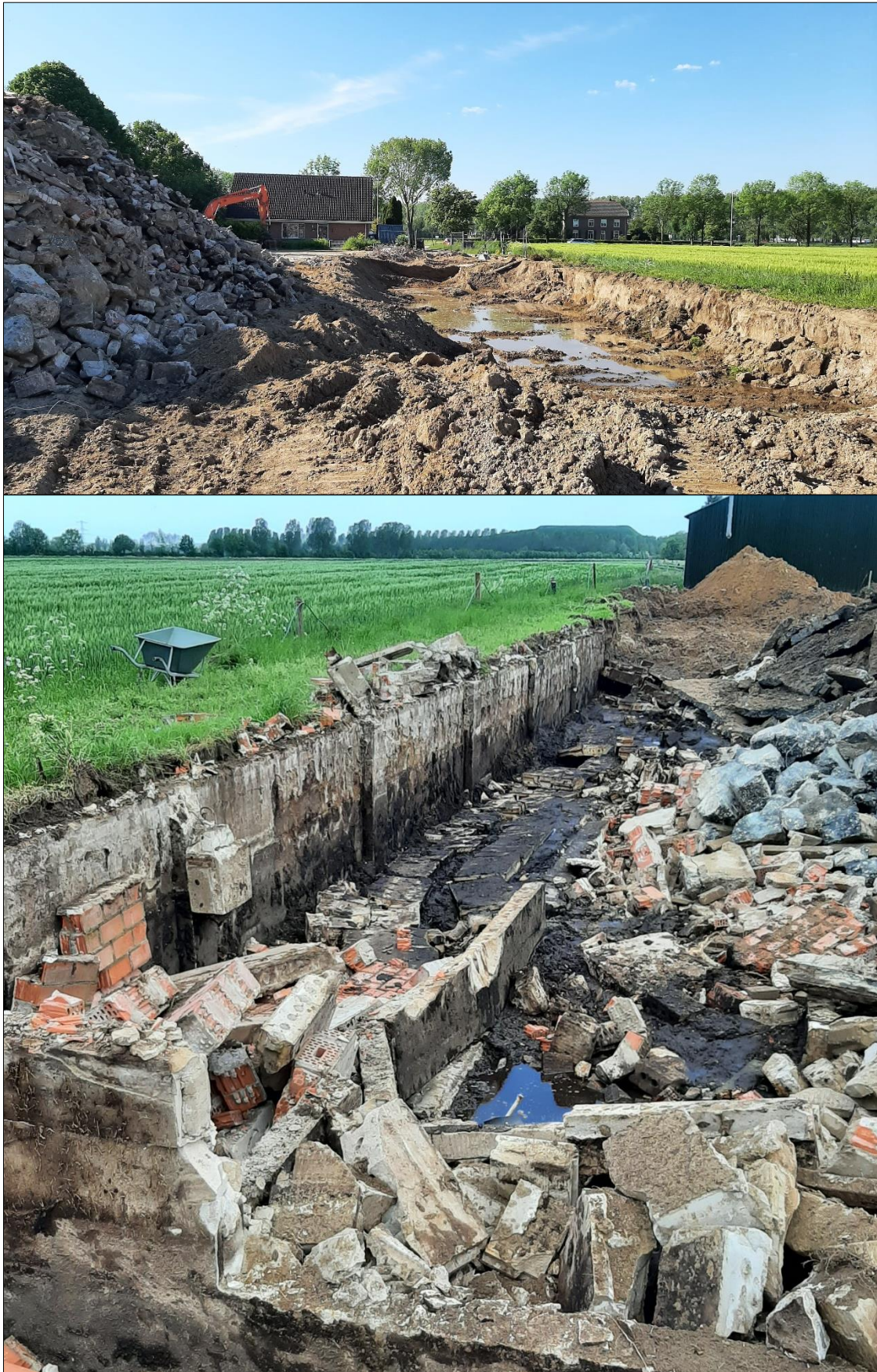
Figuur 10. Foto's van de bouwkuip van de Smalle Schuur (bron: familie Egging).
