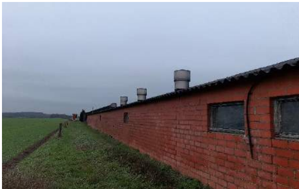
Figuur 11: Aanwezige onverharde afwateringzone
