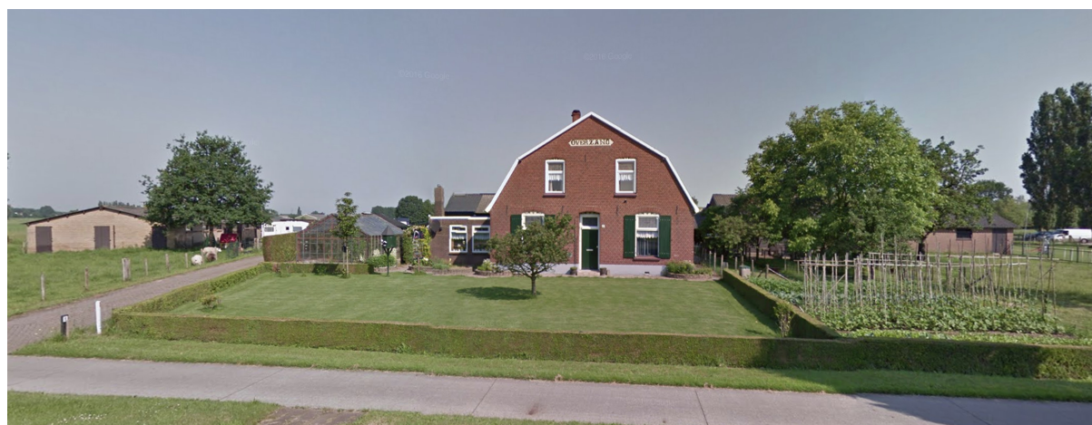
Huidige situatie plangebied, zicht op het perceel vanaf de Doetinchemseweg.
