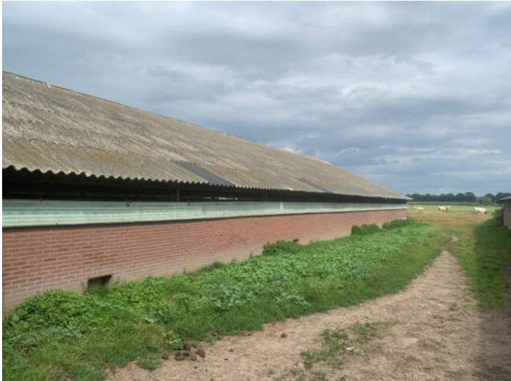
Foto 7 - Druppelzone vanwege aanwezigheid asbestverdachte dakbedekking
