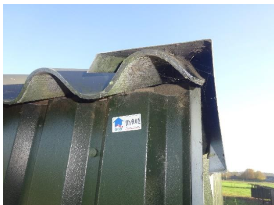
Monsternamelocatie MA02 (asbest niet aantoonbaar)
