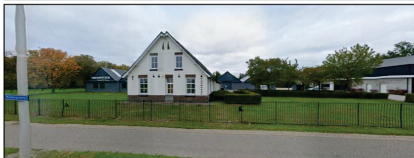
Afbeeld 4 Straatbeelden vanaf de Wijnbergseweg van het plangebied in de huidige situatie (bron: Google streetview, 2021)
