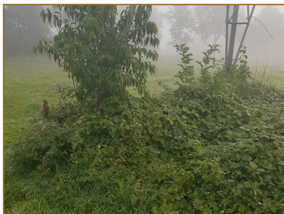
Afb. 2.6: Bramenruigte onder de hoogspanningsmast.
