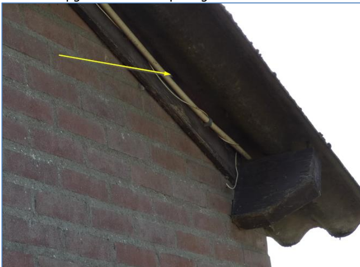
Foto 14. Plank-afdichting gevel en dak
