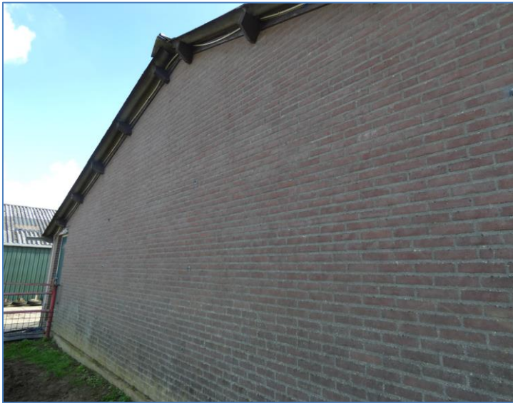
Foto 13. Kopgevel N zonder openingen
