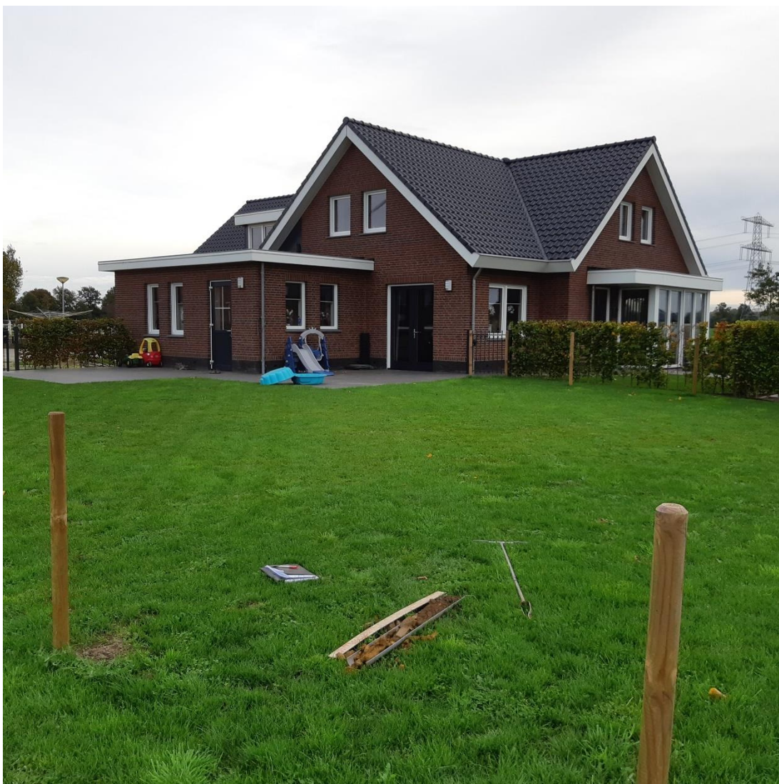
Foto van de bestaande woning a.d. Truisweg vanaf de achterzijde bij boring 6 in zuidoostelijke richting.
