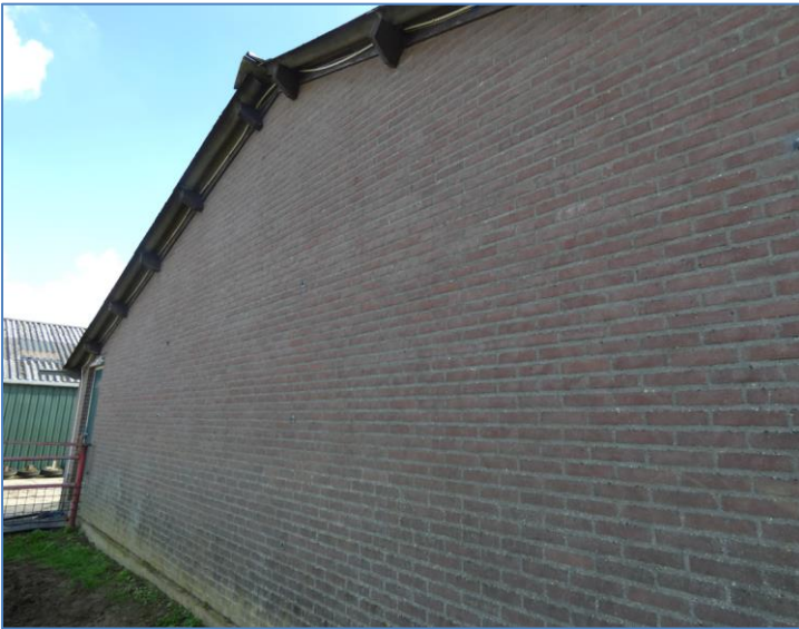
Foto 13. Kopgevel N zonder openingen
