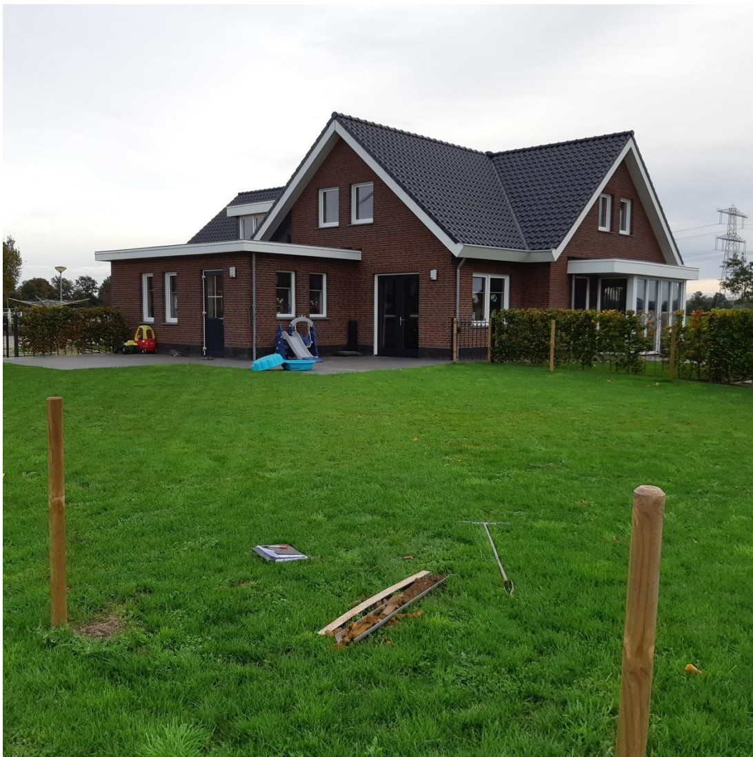
Foto van de bestaande woning a.d. Truisweg vanaf de achterzijde bij boring 6 in zuidoostelijke richting.
