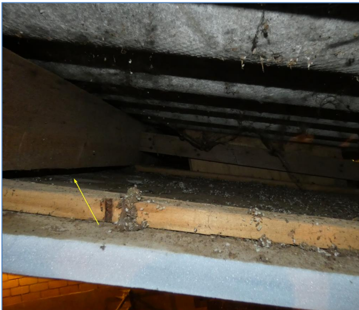
Foto 8. Tochtkier isolatie en gordingen (gele pijl)
