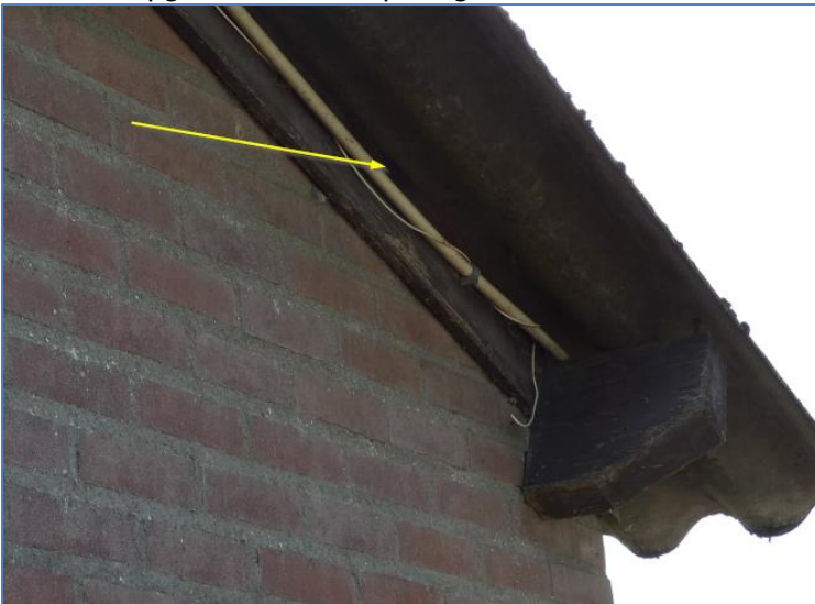
Foto 14. Plank-afdichting gevel en dak
