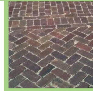
Bestrating van gebakken klinkers in verschillende verbanden en evt. kleuren
