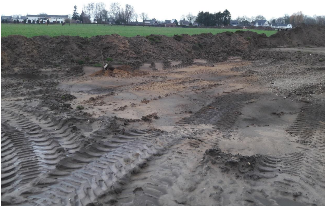
Afbeelding 13: Overzicht van de ontgraving aan de westzijde van de onderzoekslocatie
