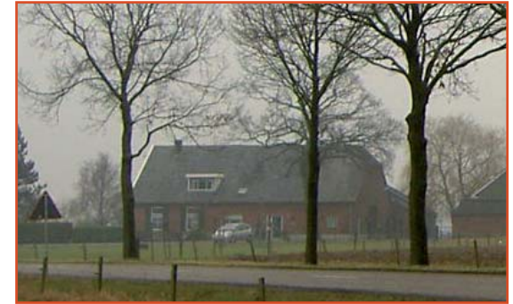
Hallehuis; lange zijgevel met groot dakvlak
