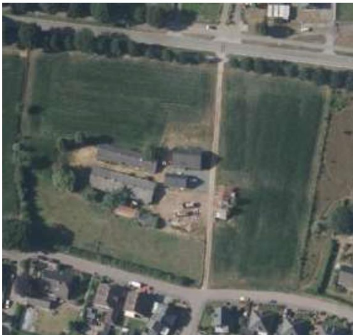
Afb. luchtfoto perceel Bosstraat 57 Didam
