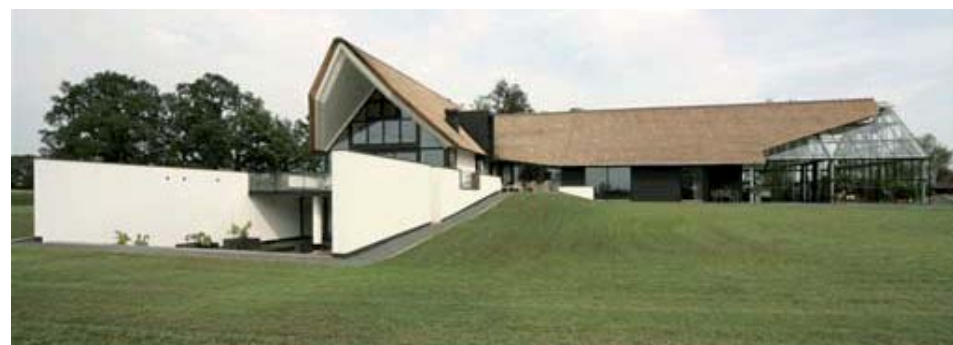
Voorbeeldfoto 1. Gelderland. Nieuwbouw woonhuis in Laren (bron: www.architectenweb.nl ) Nieuw woonhuis ter vervanging van bestaande boerderij. Eén laag met kap, geïnspireerd op T-boerderij met rieten kap (gebiedseigen). De vergraving (rechterfoto) is niet gebiedseigen en dient niet zichtbaar te zijn vanaf de openbare weg.
