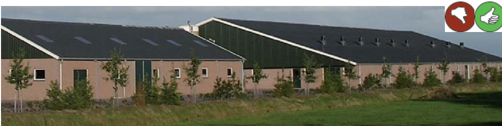
Voorbeeldfoto 3. Ongewenste dak-gevelverh. van 1:1 (voorste stal) en gewenste dak-gevelverh. van 2:1 (achterste stal).
