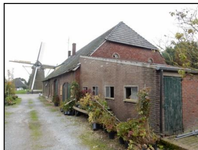
Figuur 4. Achterzijde boerderij met aangebouwde stalruimte
