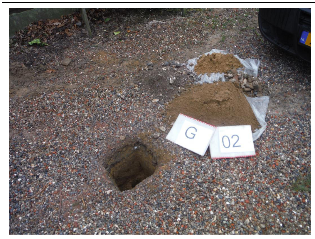
Foto 2. Asbestinspectiegat G02
