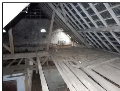
Figuur 7. Binnenzijde voormalige hooizolder
