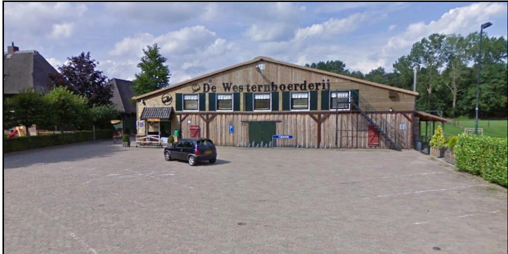
Huidige situatie aanzicht De Westernboerderij (bron: Google Earth)
