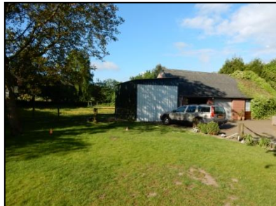
Figuur 4. Garage en schuur.
