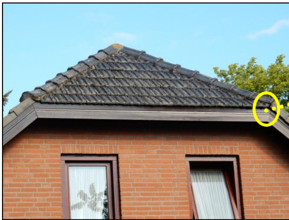
Figuur 13. De dakranden sluiten goed aan, de dakpannen zijn met cement vastgelegd. Er is op één plek een mogelijk geschikte opening voor vleermuizen. Uit nadere inspectie is gebleken dat deze niet geschikt is voor vleermuizen.
