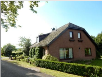
Figuur 3. Woonhuis op onderzoekslocatie.
