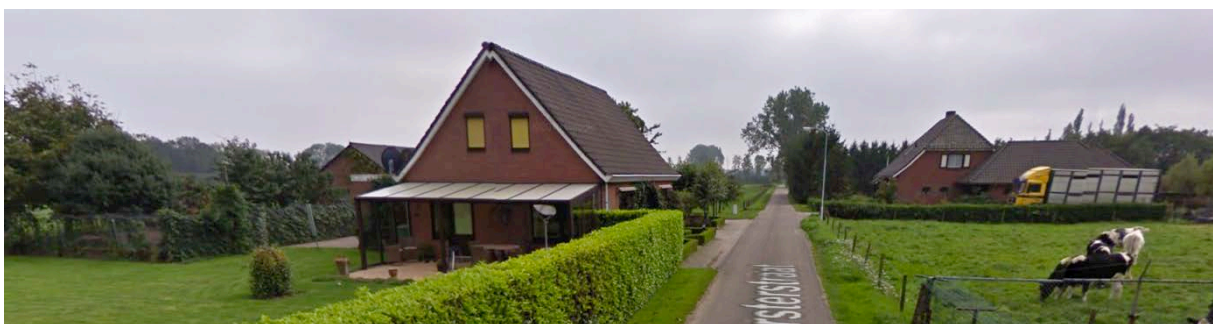
Linthorsterstraat nr 7 (links) en nr 6 (rechts)
