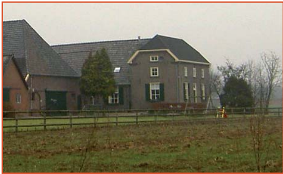
T-boerderij met donkere dakpannen
